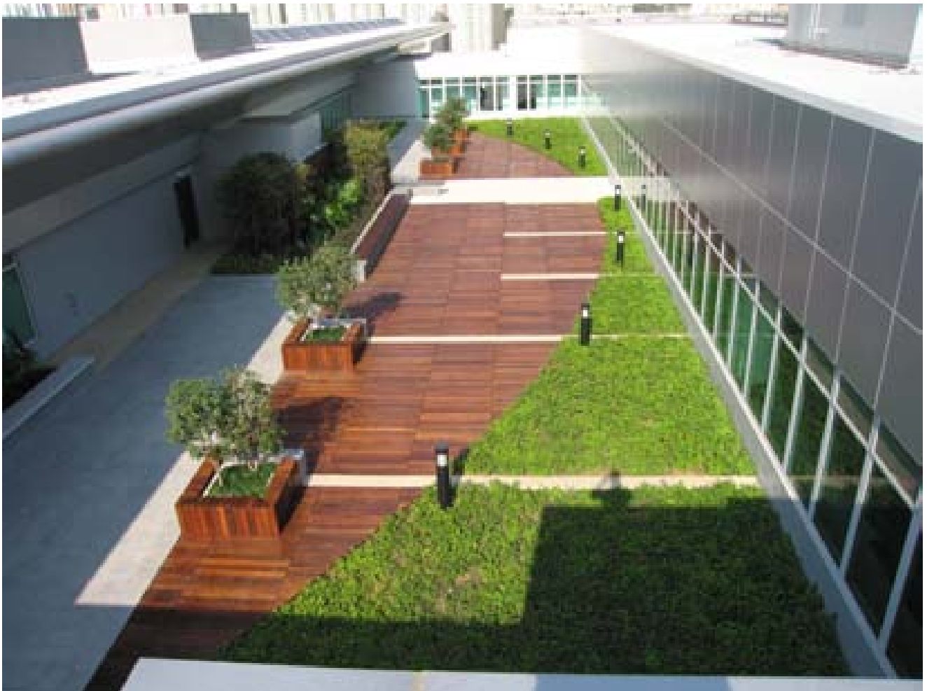
Roof garden at New EMSD Headquarter 新機電工程署總部的屋頂花園
