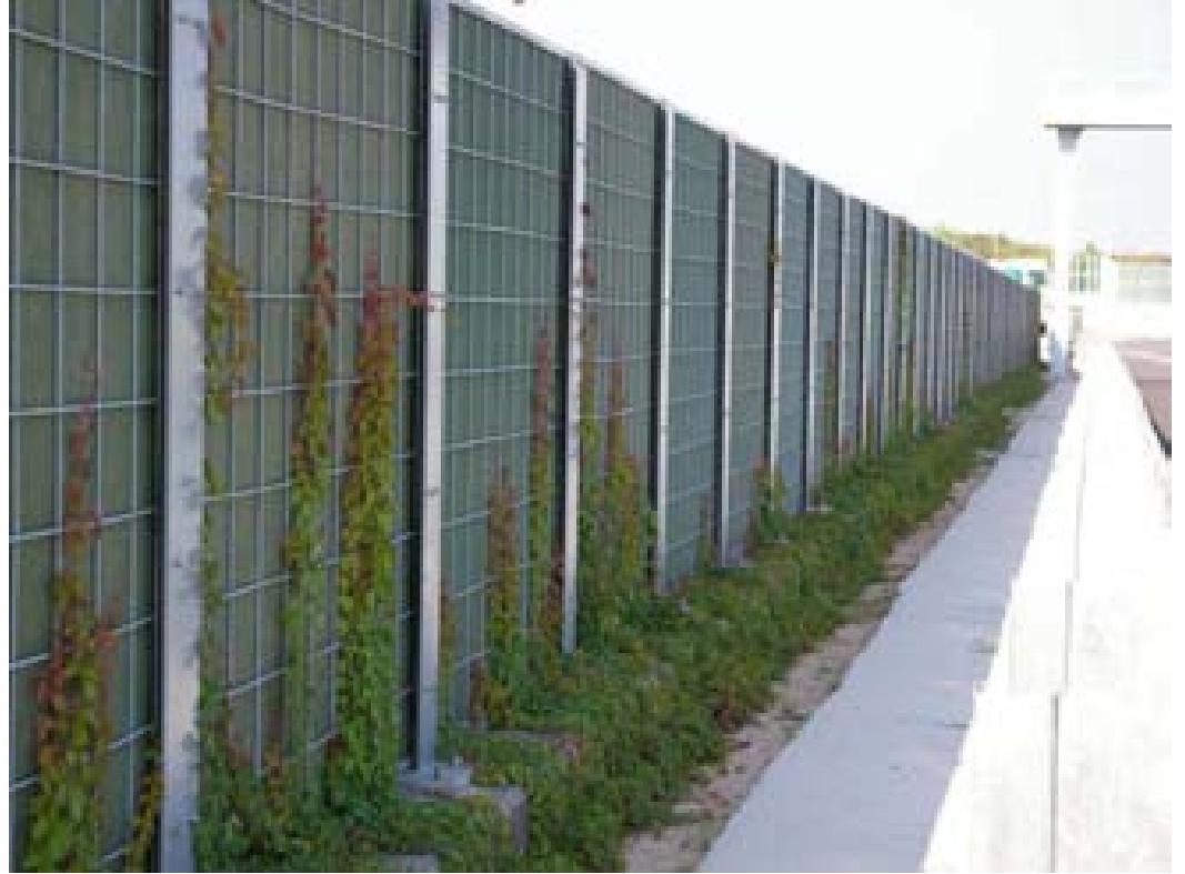
Green noise barrier on Deep Bay Link 后海灣幹線的綠化隔音屏障
