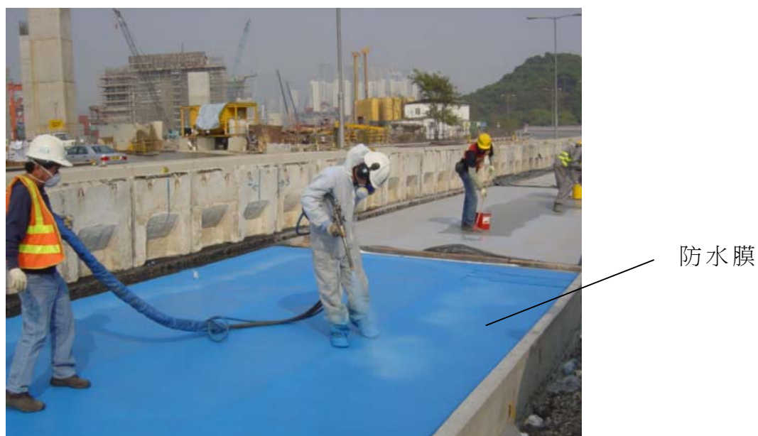
圖 4 - 在昂船洲高架道路合約下建造防水系統試驗面板
