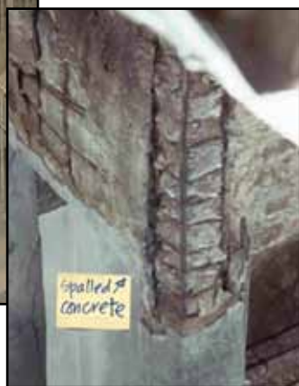
▲ 修葺柱或承重牆
