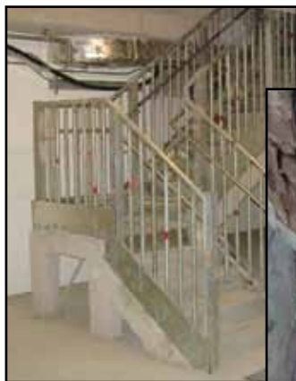
▲ 加建室內樓梯
