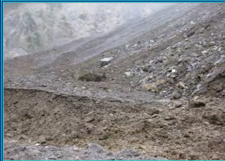
崩塌體泥石流掩埋道路
