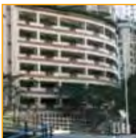
樓宇下的多層停車場
