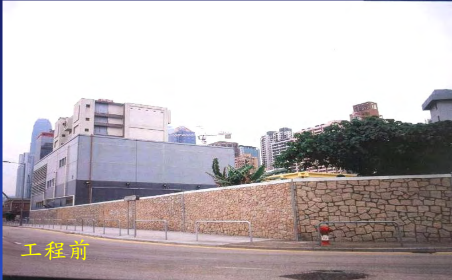
中環初級污水處理廠
