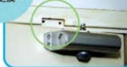
鐵閂銹蝕或損毀、滾軸輪損毀。
