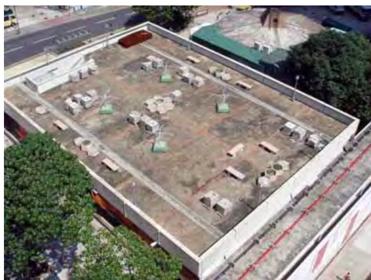
綠化前的天台
