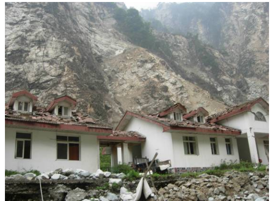
圖 3- 保護站職工住宅現況
