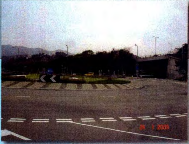
現有的景觀 EXISTING VIEW
