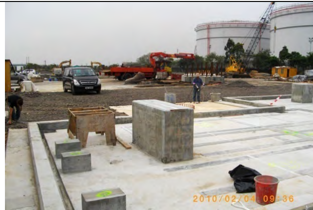
2010年2月 進展: 剛完成大型剪鐵機的基座
