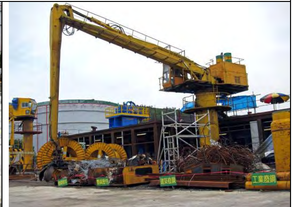
2010年5月初 進展: 大型剪鐵機的安裝工程已經完成，並已開始運作
