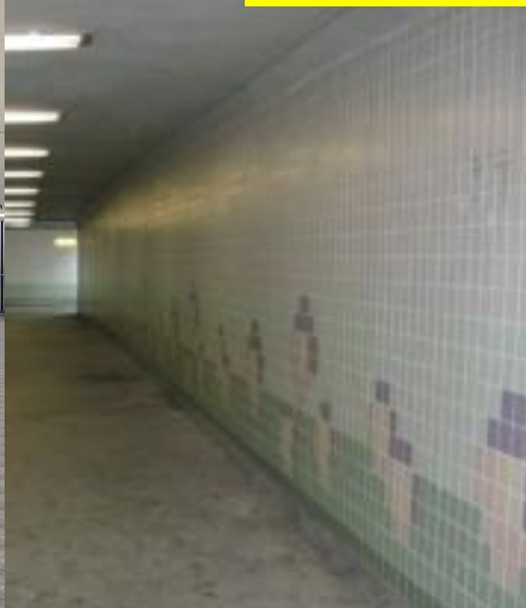
行人隧道現況
