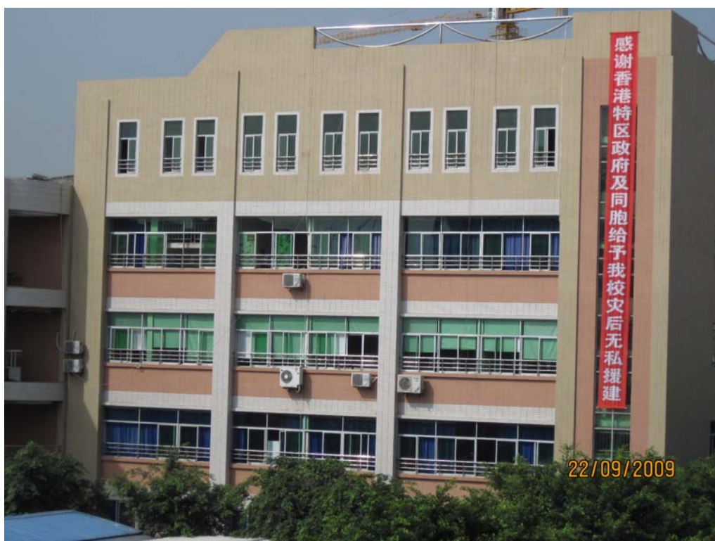
进度照片: 原校舍加固修复后正立面。
