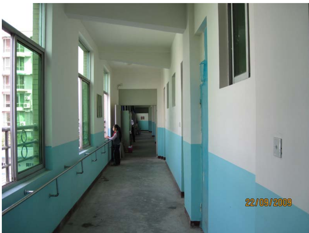
进度照片: 原校舍室内加固修复后情况。
