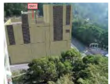
圖二：位於城門谷公園附近的通風樓
