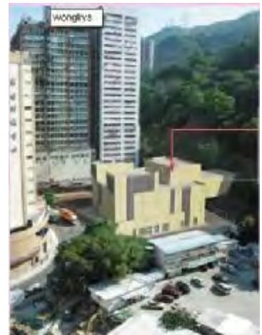
圖一：位於永業街的通風樓
