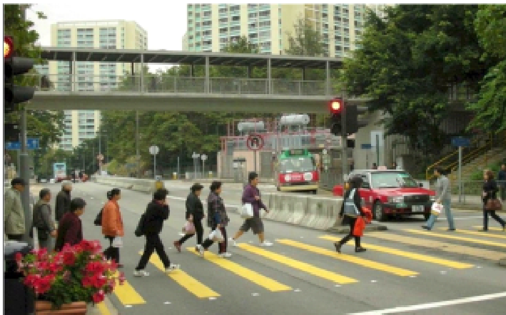
青衣上高灘街附近橫跨涌美路的行人天橋
