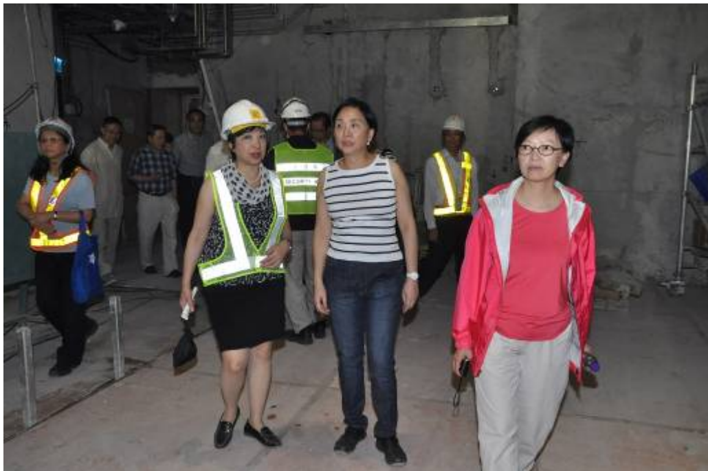
議員在綜合大樓視察工程進展。
