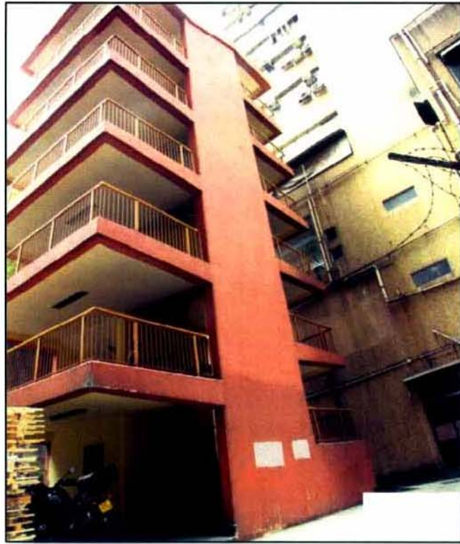
現有的景觀 Existing view
