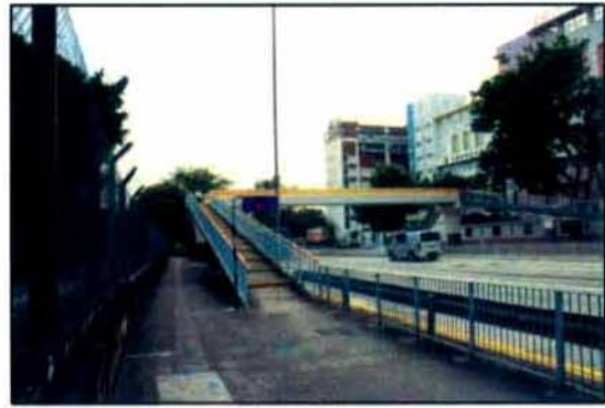
現有的景觀 Existing view
