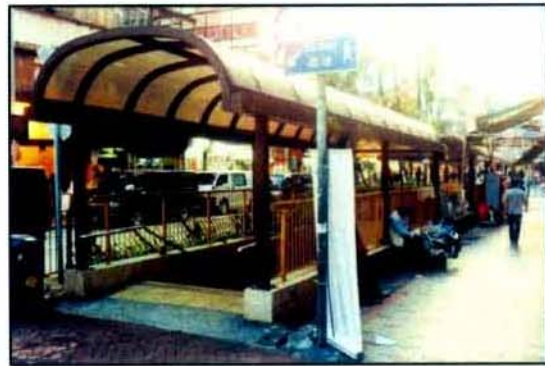
現有的景觀 Existing view
