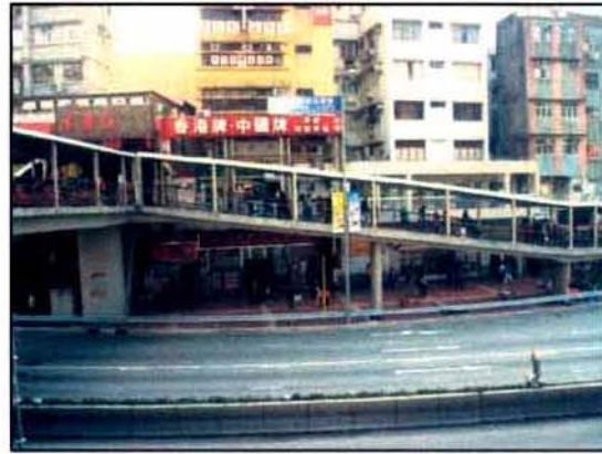
現有的景觀 Existing view
