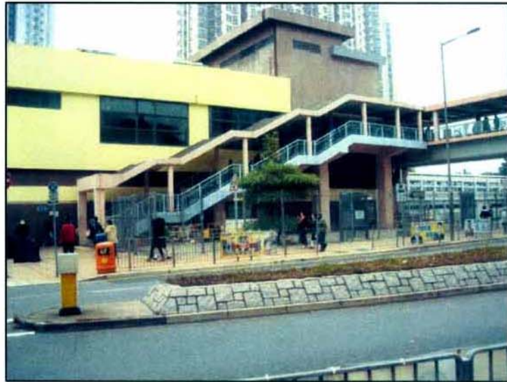
現有的景觀 Existing view
