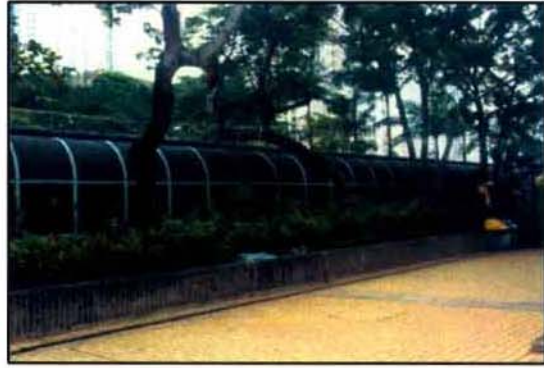
現有的景觀 Existing view
