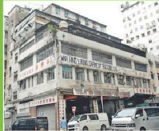
大角嘴洋松街78號工廈（圖）的非法割房（位於4樓及5樓），結構和火警安全無保證，住客安全成疑，有立法會議員贊成地政總署以更嚴厲的措施打擊違法業主。（明報記者攝）
