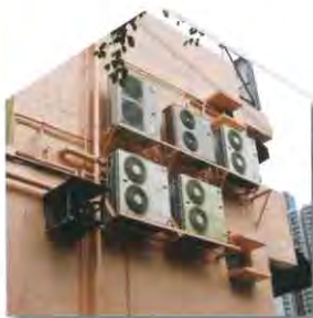
由主體建築物外牆伸建用以支承冷氣機的金屬架（必須附防止滴水設計）及冷氣機輕質篷蓋，屬可常設的小型環保及適意設施除外。
