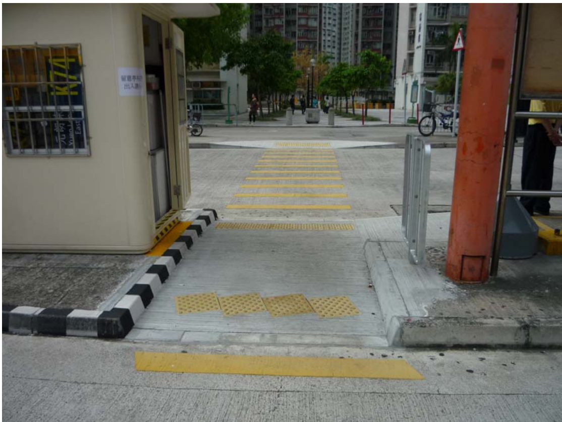
圖 2 - 下斜路緣及觸覺警示帶的實物圖片
