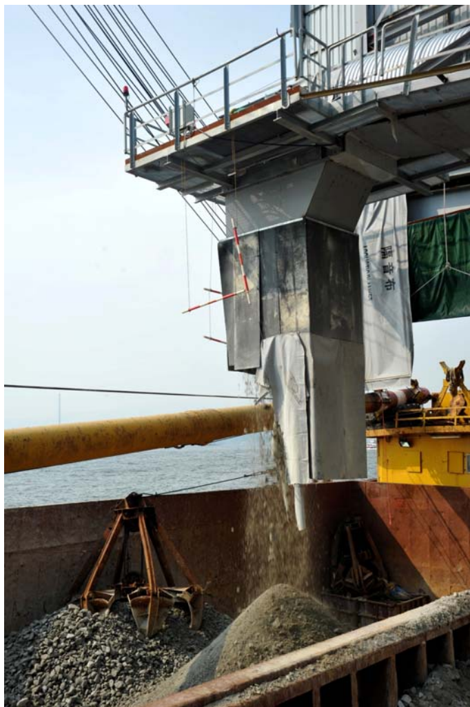
泥石輸送至躉船轉運站的卸泥台，由躉船經海路運走，減少工程對社區的影響。
