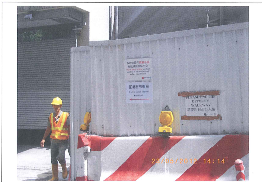
工地圍板上設置通往正街街市位置的指示牌(一)
