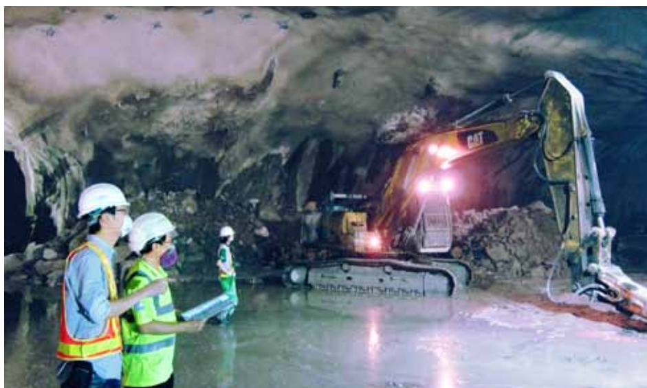
防貪處人員（左）觀察隧道工程中安裝及接駁炸藥的程序
