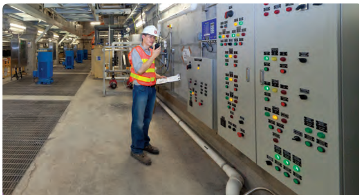
技術人員於添馬政府總部大樓檢查控制台，確保空調系統運作穩定。 Technical staff checking the control panels to ensure the reliability of the air-conditioning system at Tamar.
