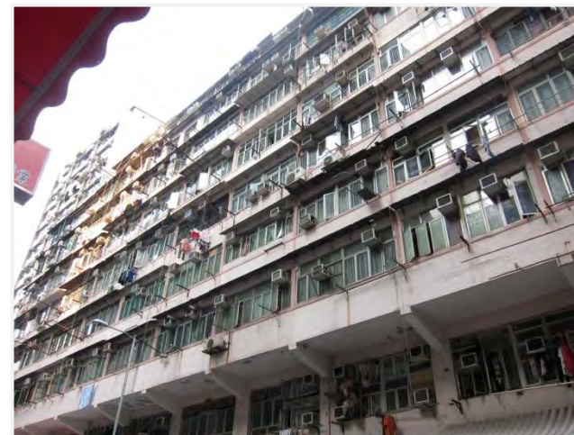
大角咀杉樹街13-31號 / 橡樹街87號
