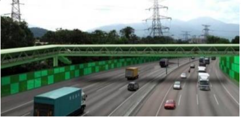
泰亨行人天橋
