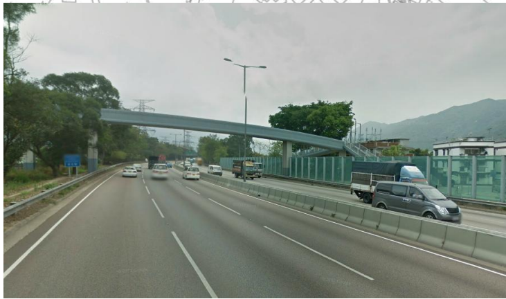
泰亨行人天橋
