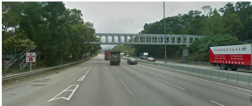
橋頭行人天橋
