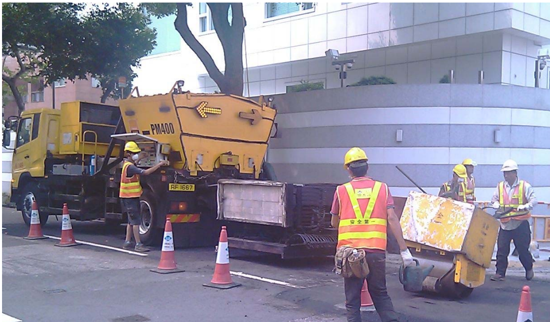
[附圖三] 熱能修路機進行小型路面重鋪工程
