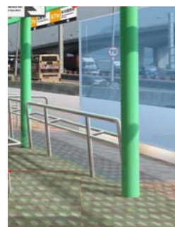
擋風板及排隊欄杆
