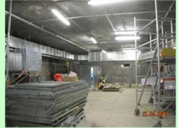
裝置機電設備 E&M installation
