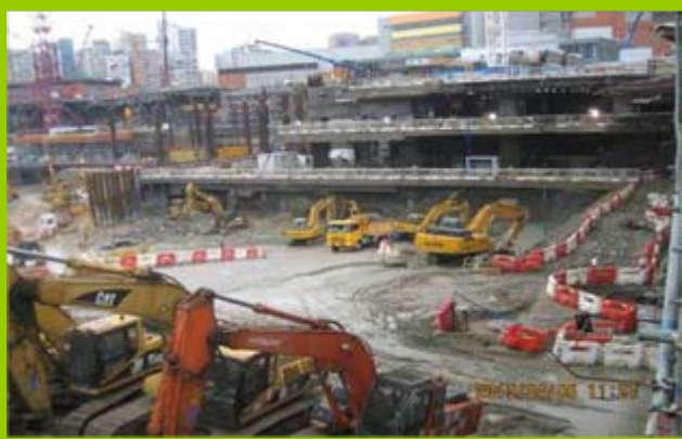
建造地下B3層 Construction of B3 slab
