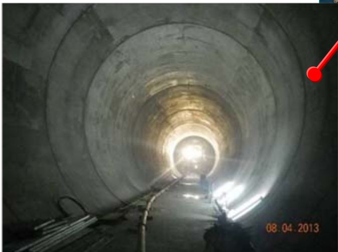
大江埔隧道工地 Tai Kong Po tunnel works site
