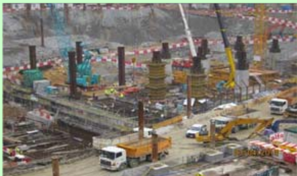
建造地下 B4 層 Construction of B4 slab
