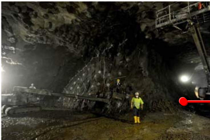
牛潭尾隧道工地
