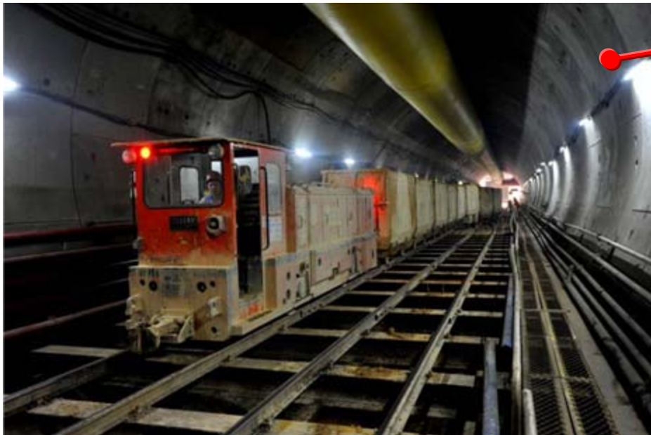
隧道工地 Tunnel works site
