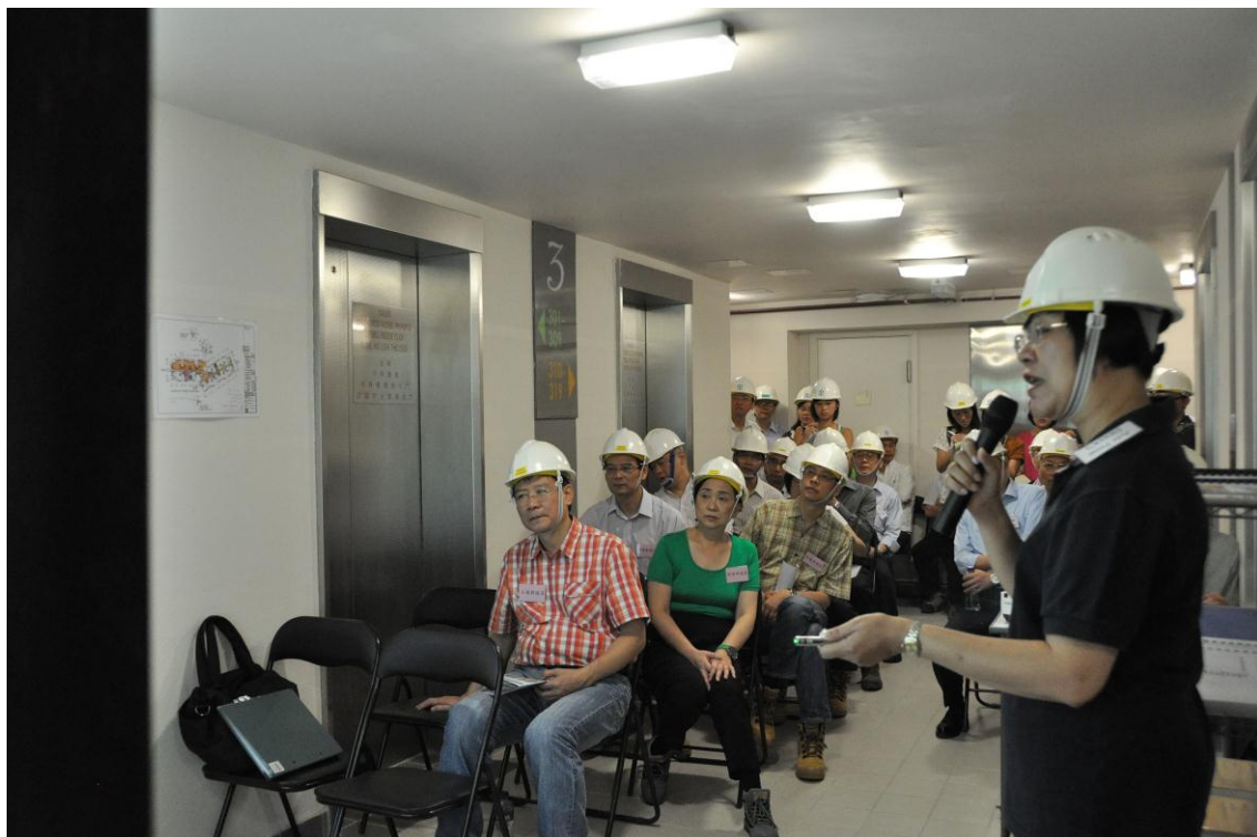
立法會議員到將軍澳第 65B 區公共租住房屋發展計劃的建築地盤視察，聽取房屋署副署長（發展及建築）馮宜萱女士（右）簡介地盤安全與質素管理措施。
