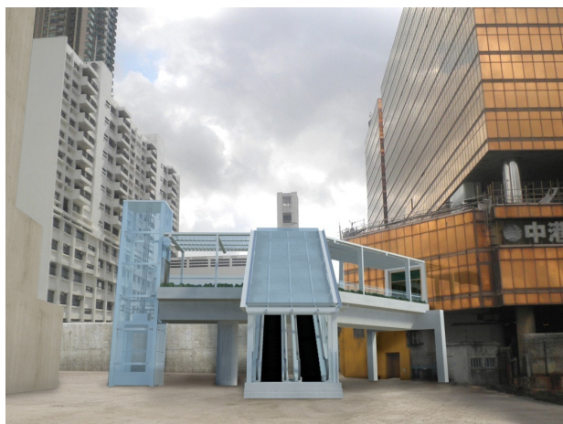
China Ferry Terminal Bridge 中國客運碼頭天橋
