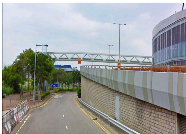
ICC Bridge 環球貿易廣場行人天橋
