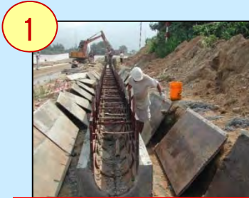
Small scale construction work 新建小型項目
