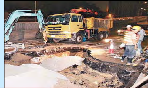
Emergency construction works 緊急建造工作
