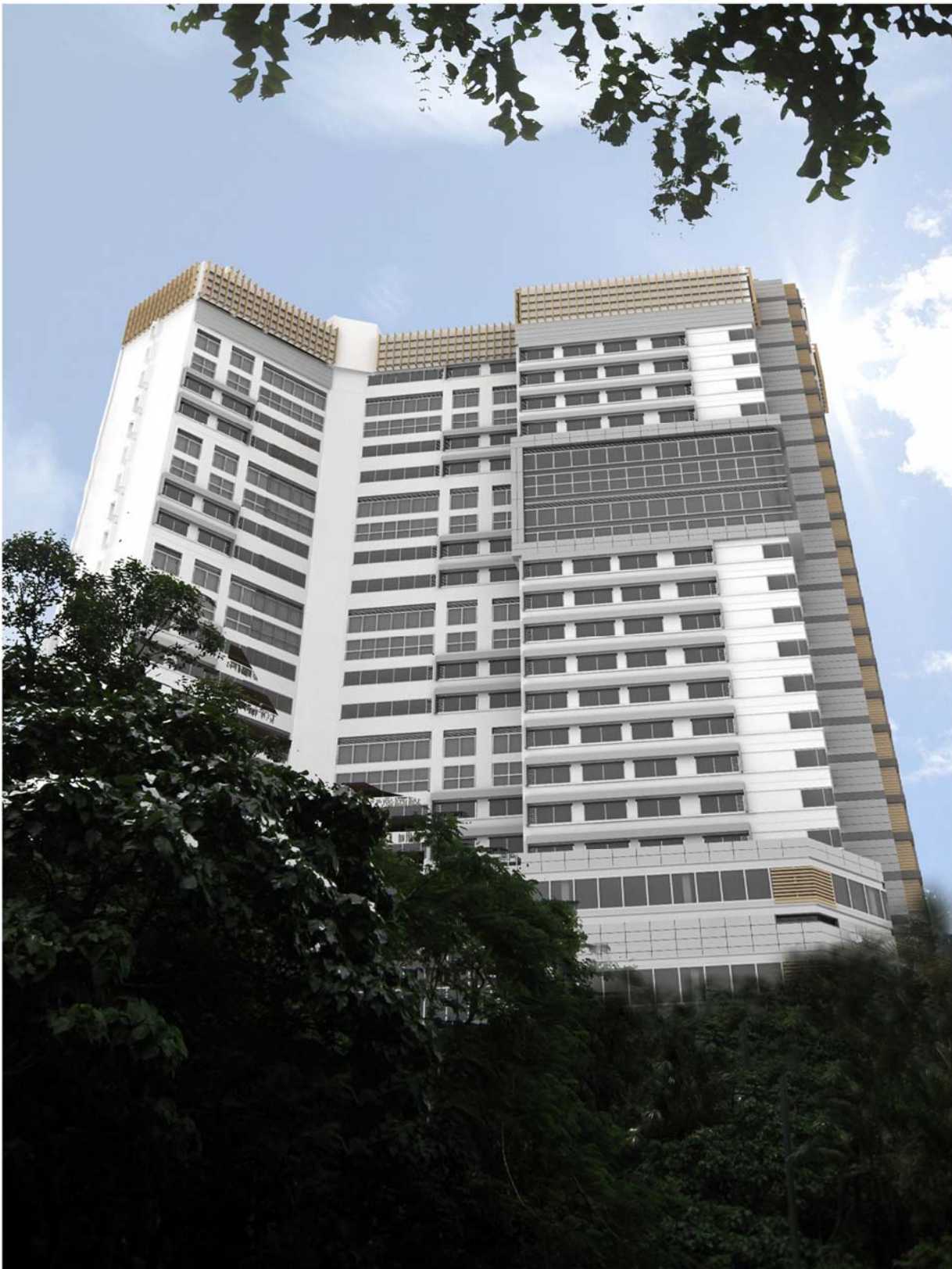
70MM - Redevelopment of Queen Mary Hospital, phase 1 瑪麗醫院重建工程第一期
