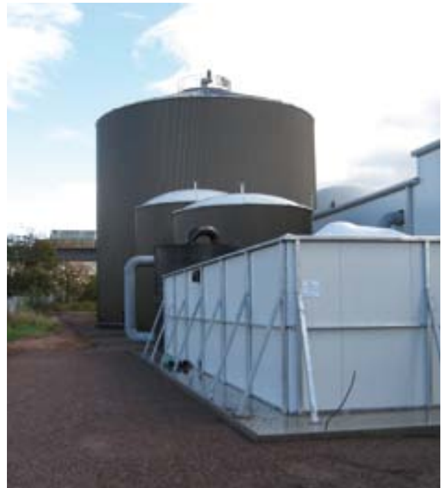
Fermenter plus biofilter
