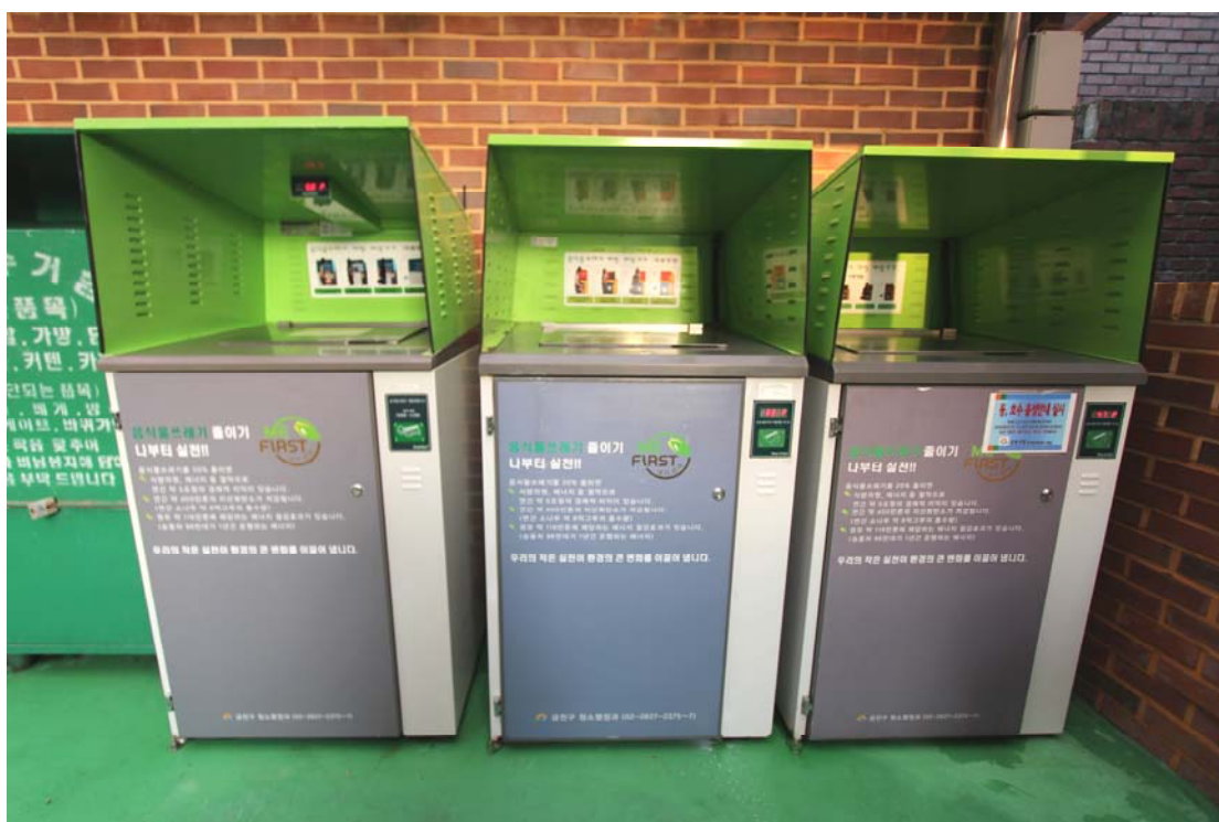
裝有無線射頻識別標籤的收集桶用作記錄每個住戶所產生的廚餘
