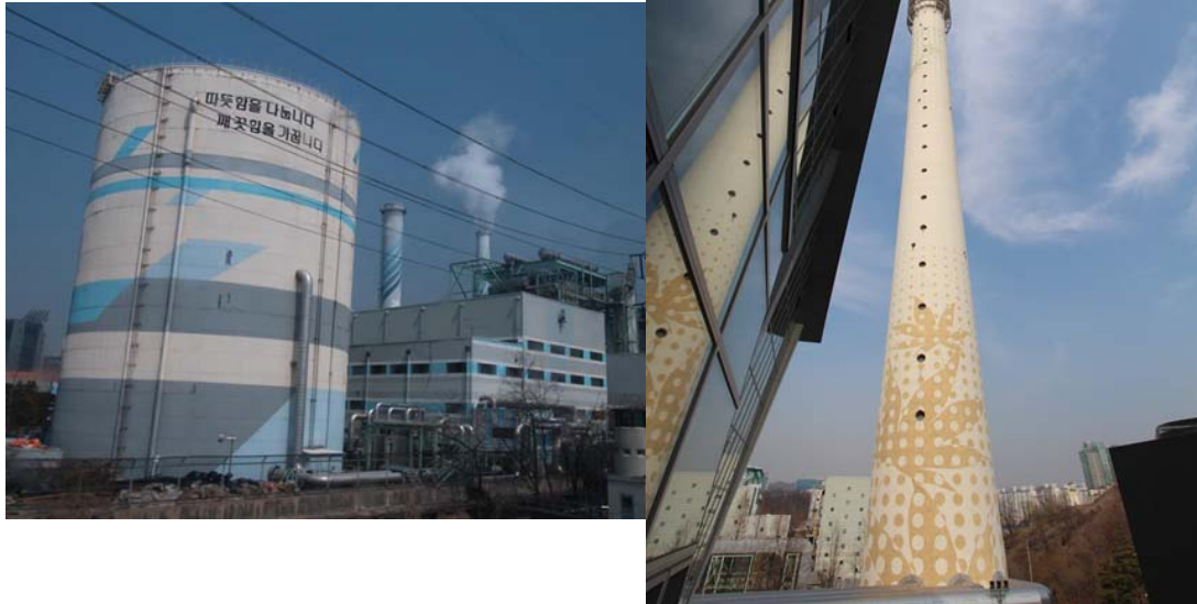
從麻浦轉廢為能設施的煙囪排出經過濾的氣體
