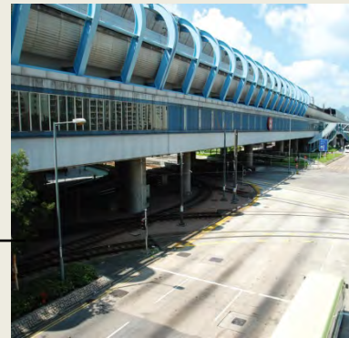
西鐵天水圍站 West Rail TSW Station
