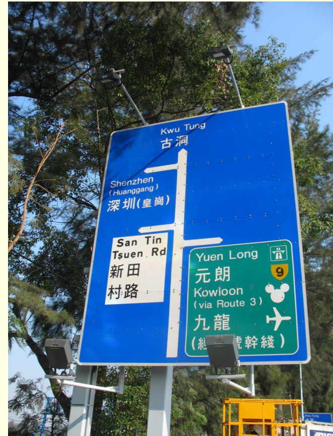
路邊道路標誌照明
