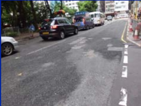
已損耗路面
