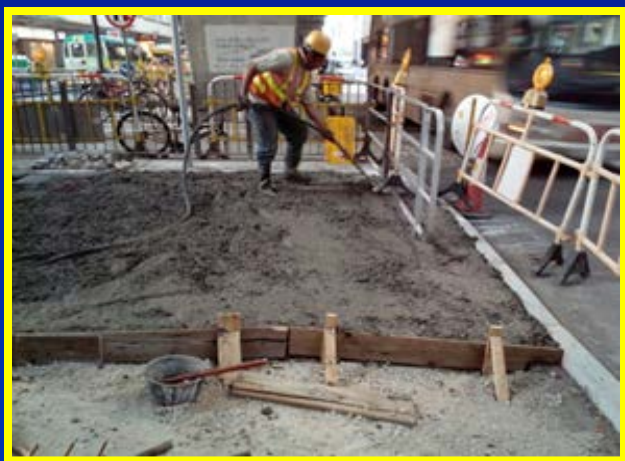
現場澆注混凝土
