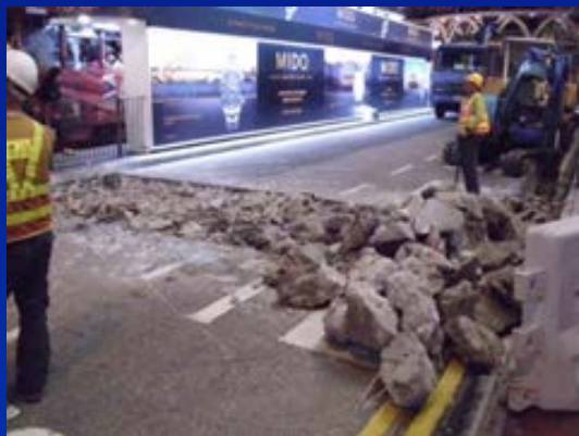
掘走原有路面
