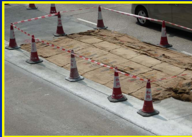
混凝土養護 - 等待足夠強度
