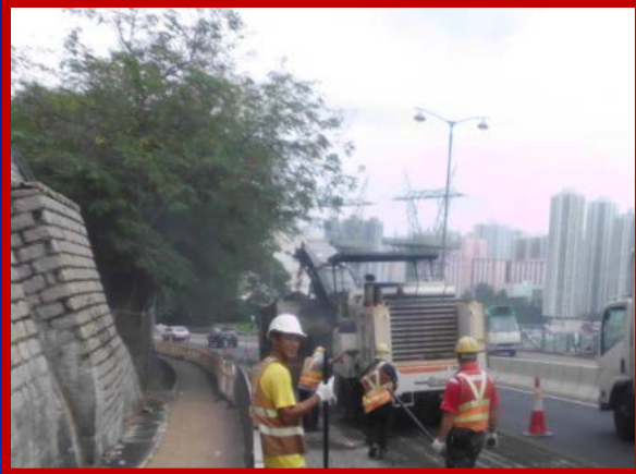
刨去損耗路面
