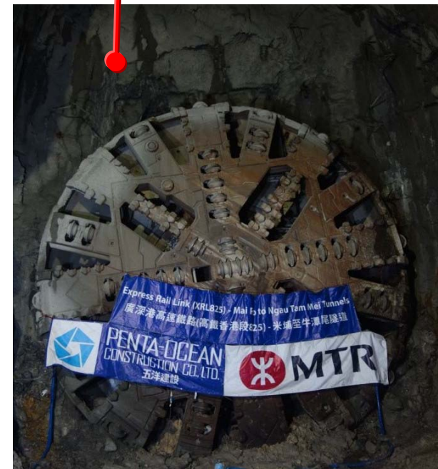
第一條南行隧道的鑽挖工程已於2013年7月完成 TBM excavation for the 1st down-track tunnel completed in July 2013
