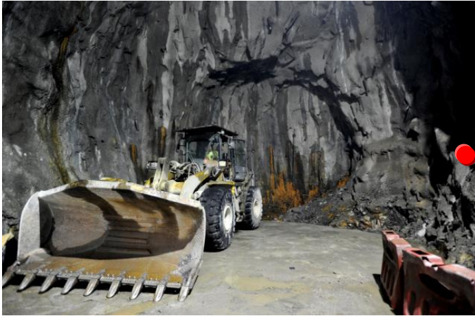
牛潭尾隧道工地 Ngau Tam Mei tunnel works site
