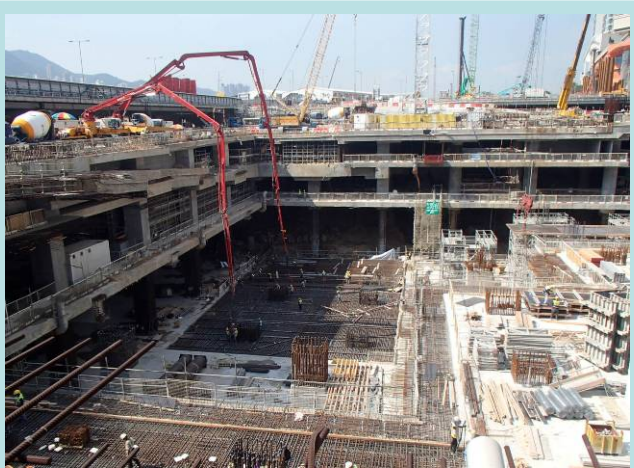
建造地下B4層 Construction of B4 slab
