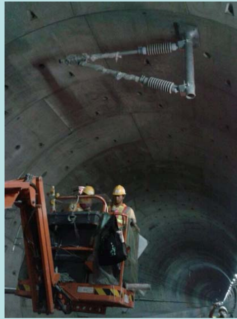
高架電纜懸臂 OHL Cantilever
