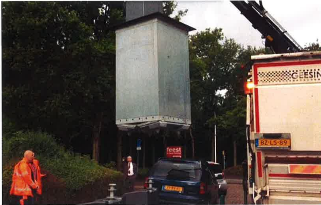
(機械車正在拉起位於地下的 WSS 垃圾儲存庫)
