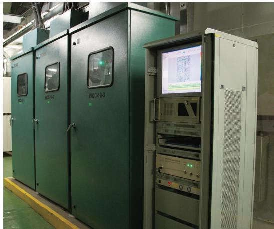
光傳感有限公司於能源大樓一座安裝其分佈式感溫系統，可實時監察系統溫度。
