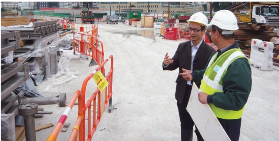
防貪處人員(左)在工地觀察工務工程項目的付款程序
