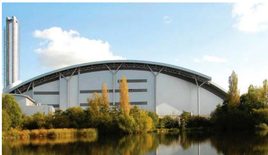
Lakeside轉廢為能設施
