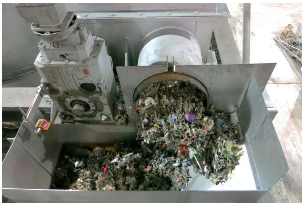
廢物衍生燃料被切割和攪碎，以便處理、運送及儲存
