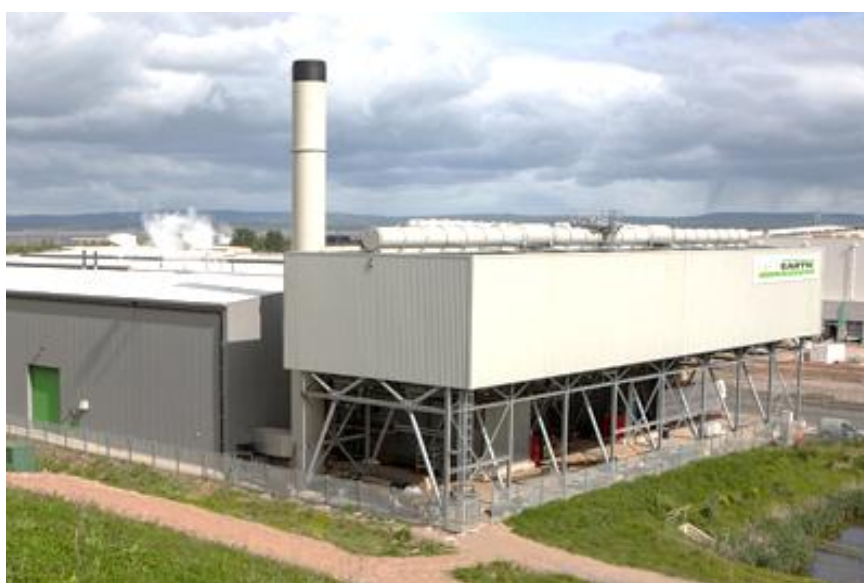
New Earth Solutions的熱解和氣化工廠
