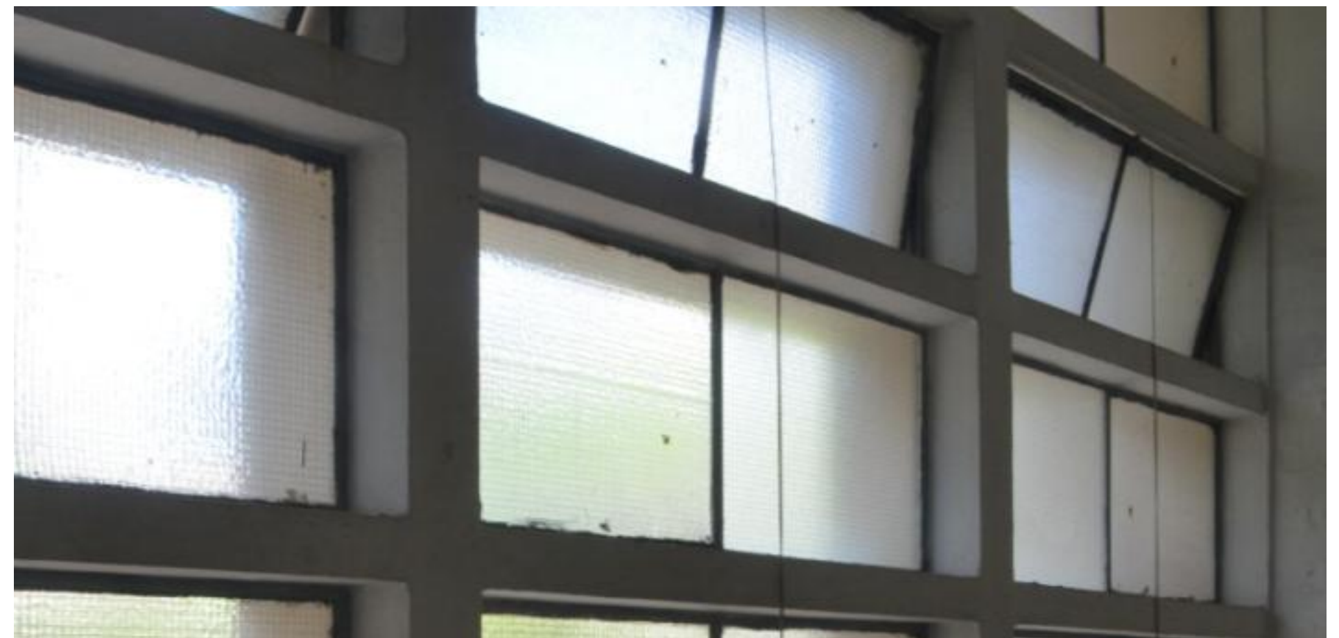
Windows with concrete grilles and wire glass 保留現有的混凝土格柵和鋼絲網玻璃
