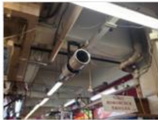
該街市天花可見已安裝多項排氣、風槽及風扇設備
