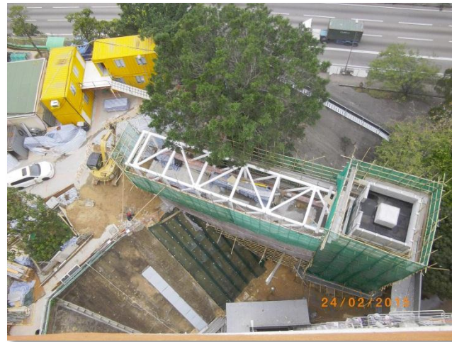
荔景邨 (升降機塔及行人天橋工程進行中)
