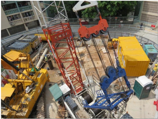
愛民邨 (地基工程進行中)
