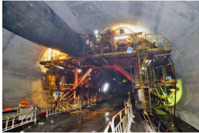
南風隧道隧道壁工程
