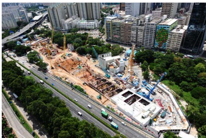
鑽石山站擴建工程
