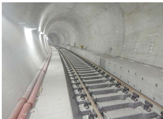
油麻地段路軌鋪砌工程
