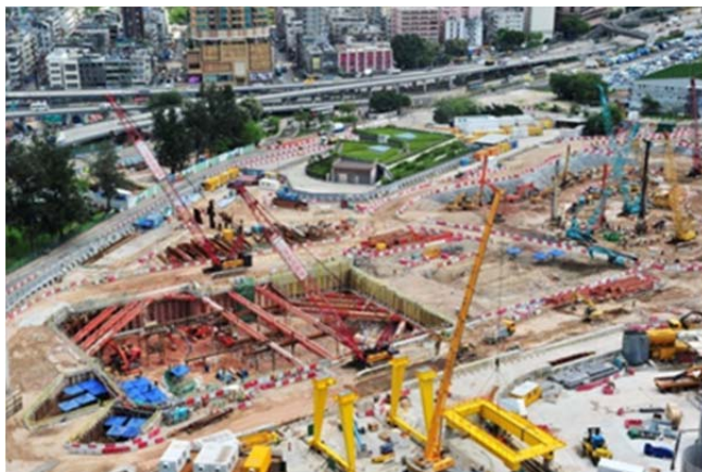
土瓜灣站工地
