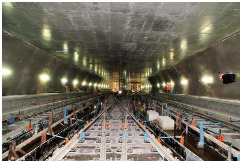
鴨脷洲隧道路軌鋪設工程
