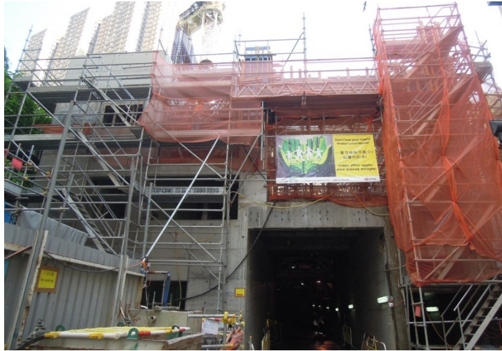
利東站 A 出入口結構工程
