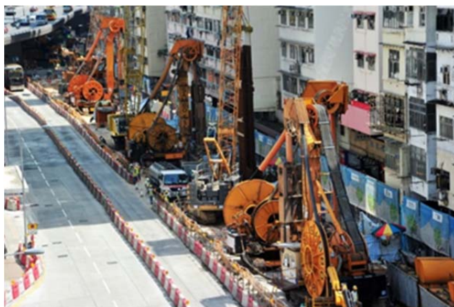
馬頭圍站工地
