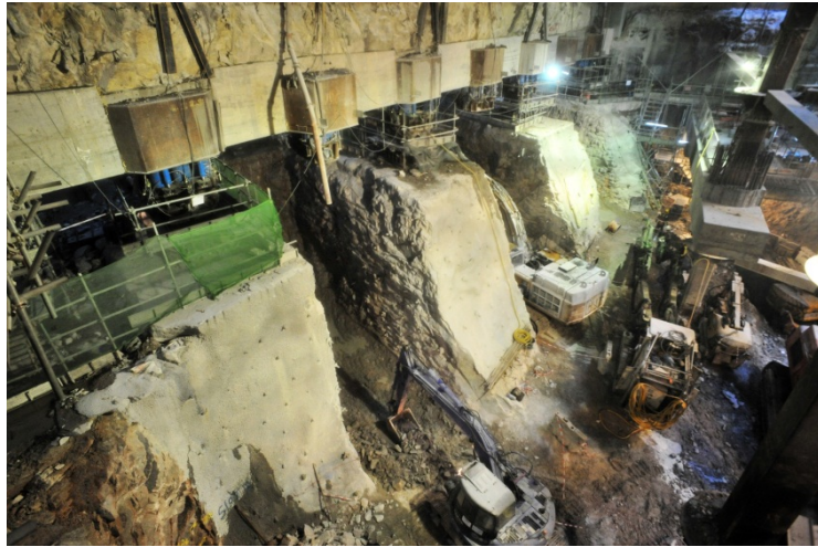
金鐘站港島綫隧道支撐架工程
