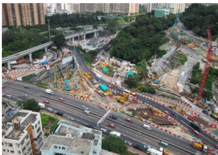
紅磡站以北的鋼管樁工程
