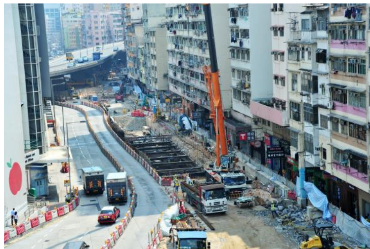
馬頭圍站工地
