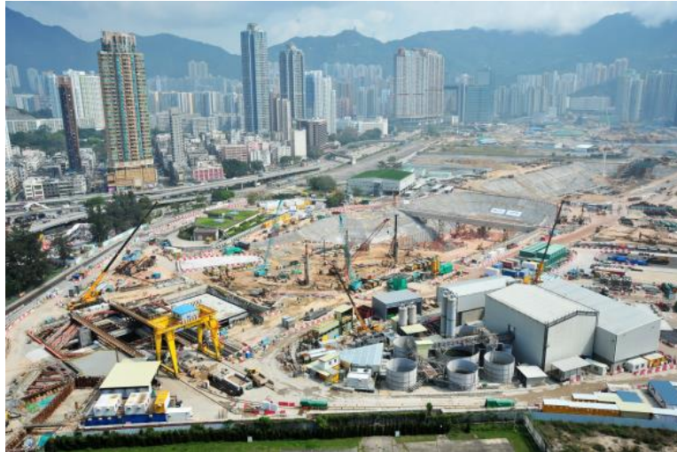
土瓜灣站工地
