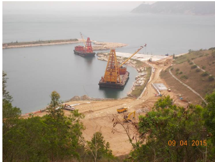
沉管隧道預製組件工場
