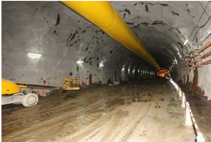
位於獅子山內的隧道建造工程
