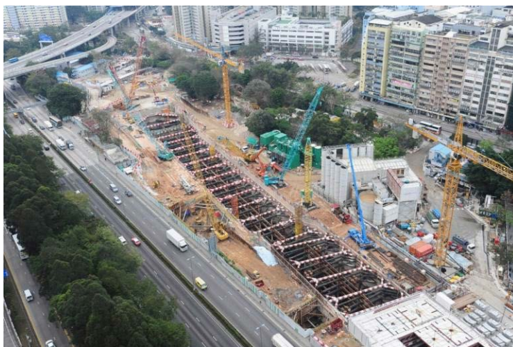
鑽石山站擴建工程
