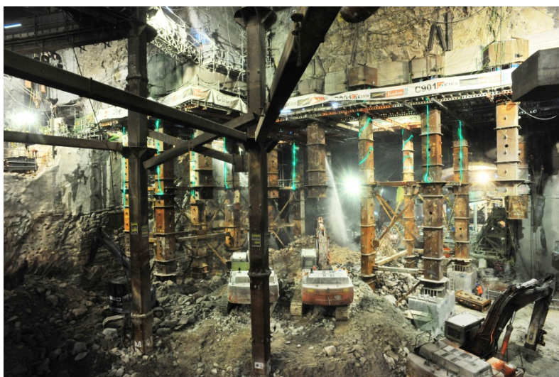
金鐘站港島綫隧道支撐架工程
