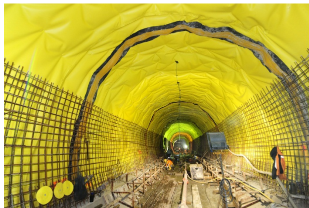
黃埔站越位隧道的隧道壁工程
